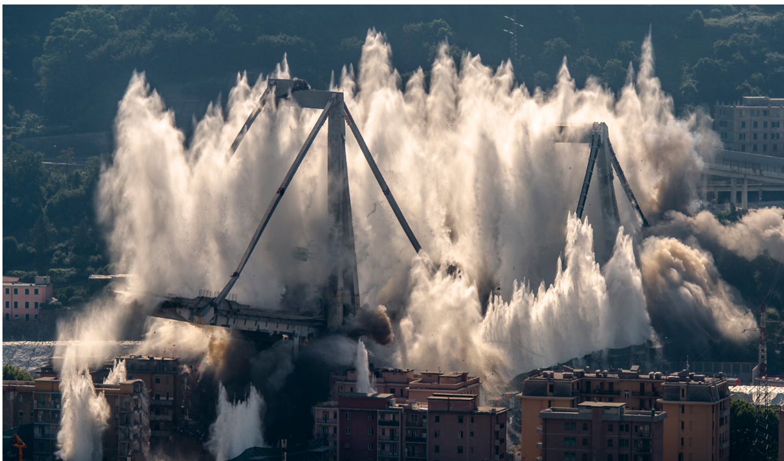
Restos del antiguo puente a demoler para dar paso a una nueva construcción
