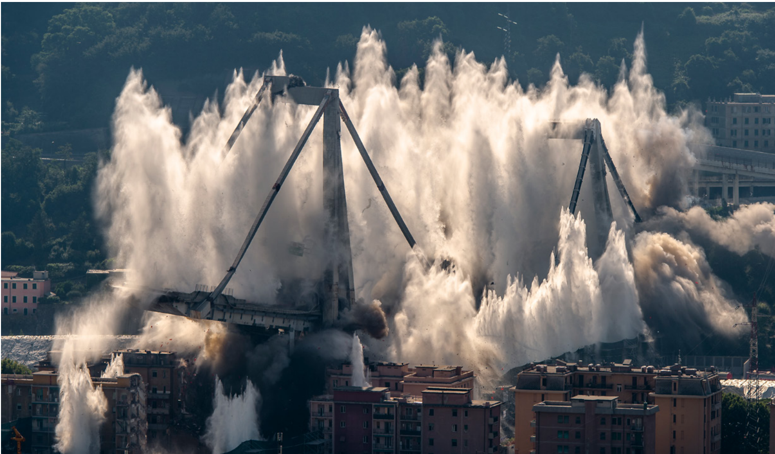
Uuden sillan rakentamiseksi vanhan jäänteet täytyi purkaa
